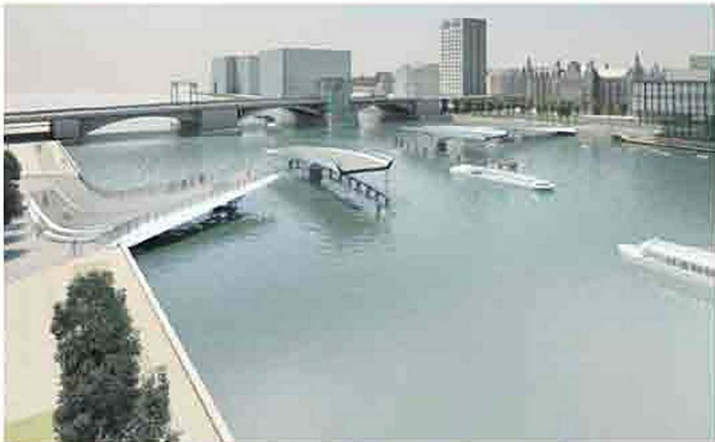
fiets- en voetgangersbrug in Kopenhagen, draait open voor scheepvaartverkeer
