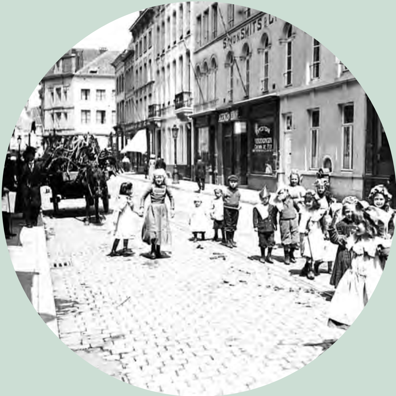
De Sint-Katelijnevest anno 1907, toen stadsstraten veel meer dan vandaag een gedeelde publieke ruimte waren.
