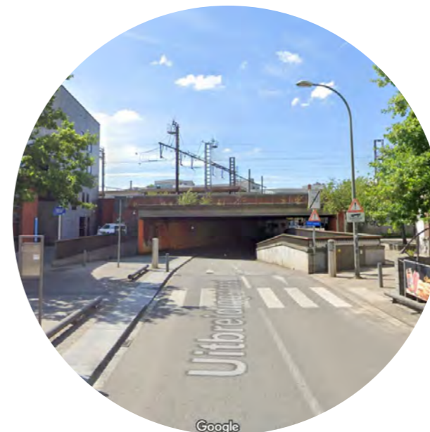
De Uitbreidingsstraat naast het Burg. E. Ryckaertsplein aan het station van Berchem is voorzien van verdwijnpalen, zodat de verbinding enkel door lijnbussen gebruikt kan worden.
