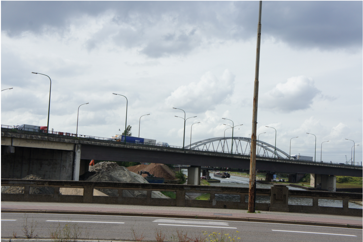
Figuur 95 Viaduct R1 over het Albertkanaal (bestaande toestand) (eigen foto)
