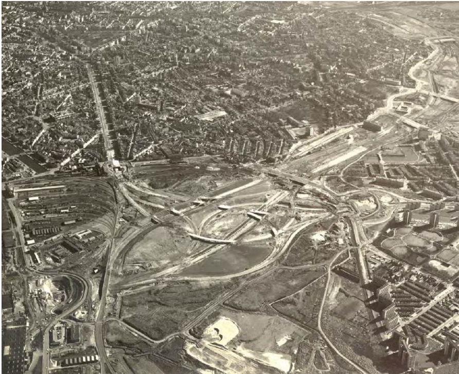
Figuur 92 De Kennedytunnel en de R1 tijdens de aanleg
