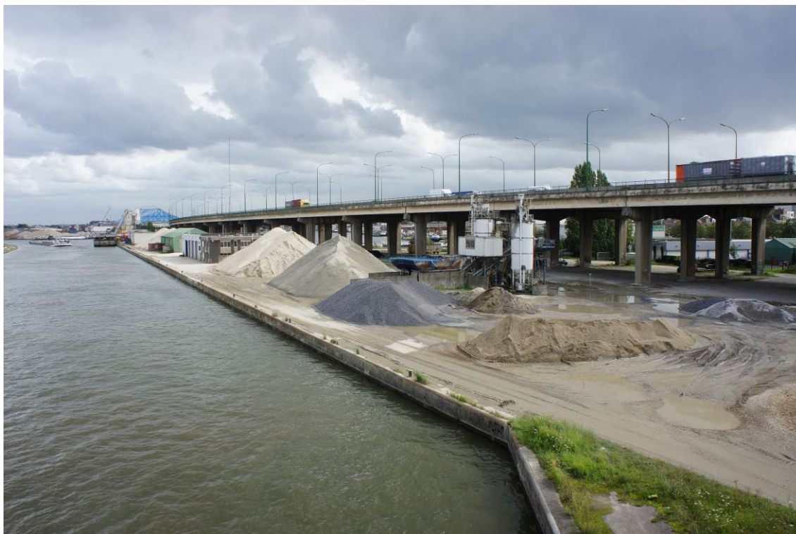
Figuur 74 Viaduct van Merksem: actuele toestand (eigen foto)
