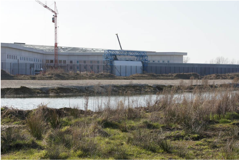
Figuur 40 Nieuwe gevangenis van Beveren in aanbouw (eigen foto)
