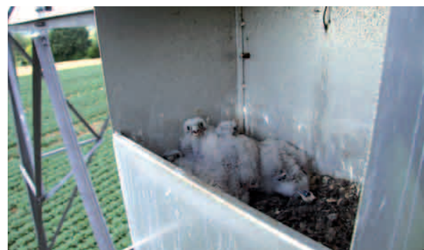
In hoogspanningsmasten worden nestkasten voor torenvalken geïnstalleerd.
