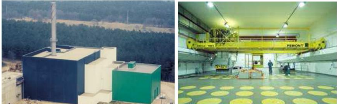
Figuur 8: Gebouw B136 voor de opslag van afval van categorieën B en C
