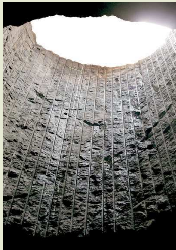
Schacht van de installatie voor het karakteriseren van de gastformatie in Olkiluoto (Finland), die één van de toegangen zal vormen tot de toekomstige geologische bergingsinstallatie, waarvan de exploitatie gepland is vanaf 2020. (bron: Posiva)
