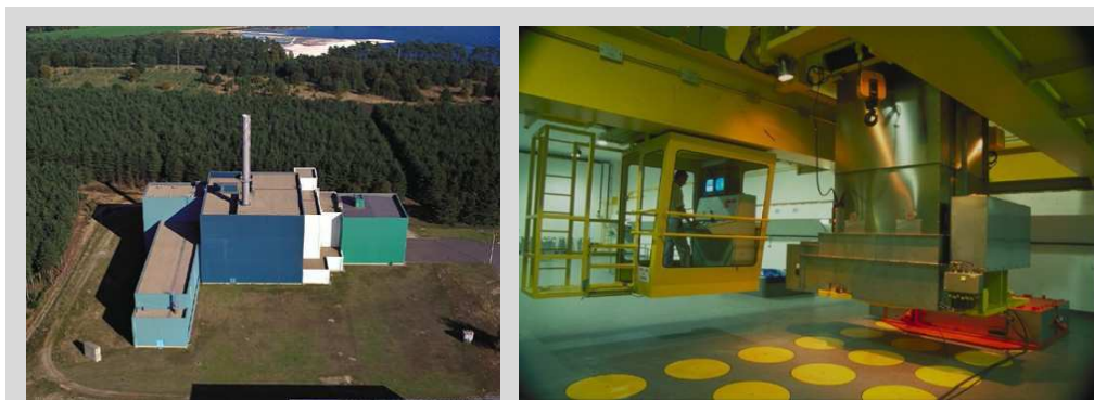
Figuur 9 – Buiten- en binnenaanzicht van gebouw 136 bij Belgoprocess, bestemd voor de opslag van hoog- en middelactief afval. Dit opslaggebouw is ontworpen om te weerstaan aan extreme externe omstandigheden, zoals aardbevingen, ontploffingen of het neerstorten van militaire vliegtuigen. De containers, die er vanop afstand behandeld worden vanuit een afgeschermd bedieningszaal, zijn opgestapeld in silo's uitgerust met een ventilatiesysteem om de afgegeven warmte af te voeren. Voor een container van 450 kg is deze warmte aanvankelijk vergelijkbaar met die van een elektrische huisradiator met een vermogen van 2 000 W.
