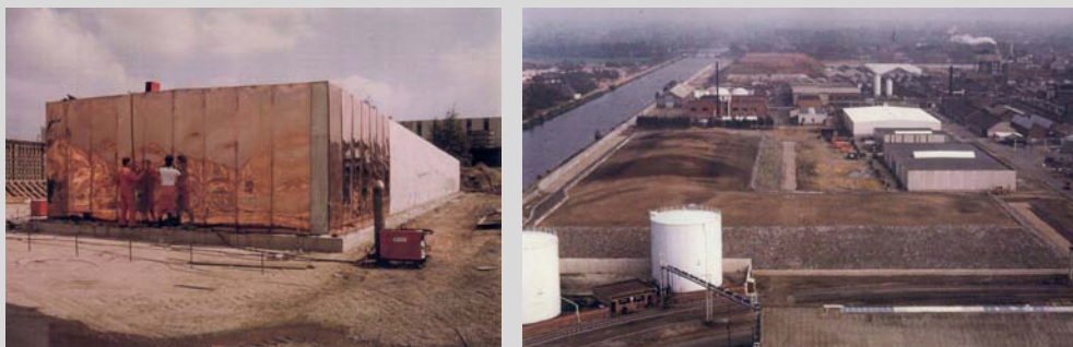
Figuur 35 – De vergunde installatie voor tijdelijke opslag UMTRAP van Umicore in Olen. Links: plaatsing van de koperen insluiting op een betonnen bunker; rechts: algemeen aanzicht van de site na het plaatsen van de deklagen. (bron: Umicore)
