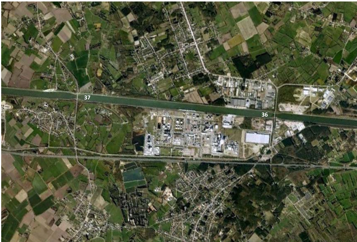
Figuur: Albertkanaal t.h.v. Eindhout
